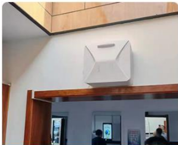
01 / 商场办公楼卫生间
